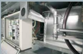
Installationsfach für Energie- und Wasseranschlüsse
